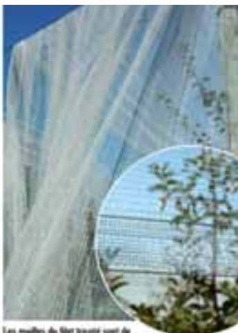
Les mailles du filet tricoté sont de forme triangulaire avec un renfort de fil de trame sur une autre chaîne tous les trois centimètres. Un fil noir à l'endroit des costures permet de bien positionner le fil au moment de la pose.
